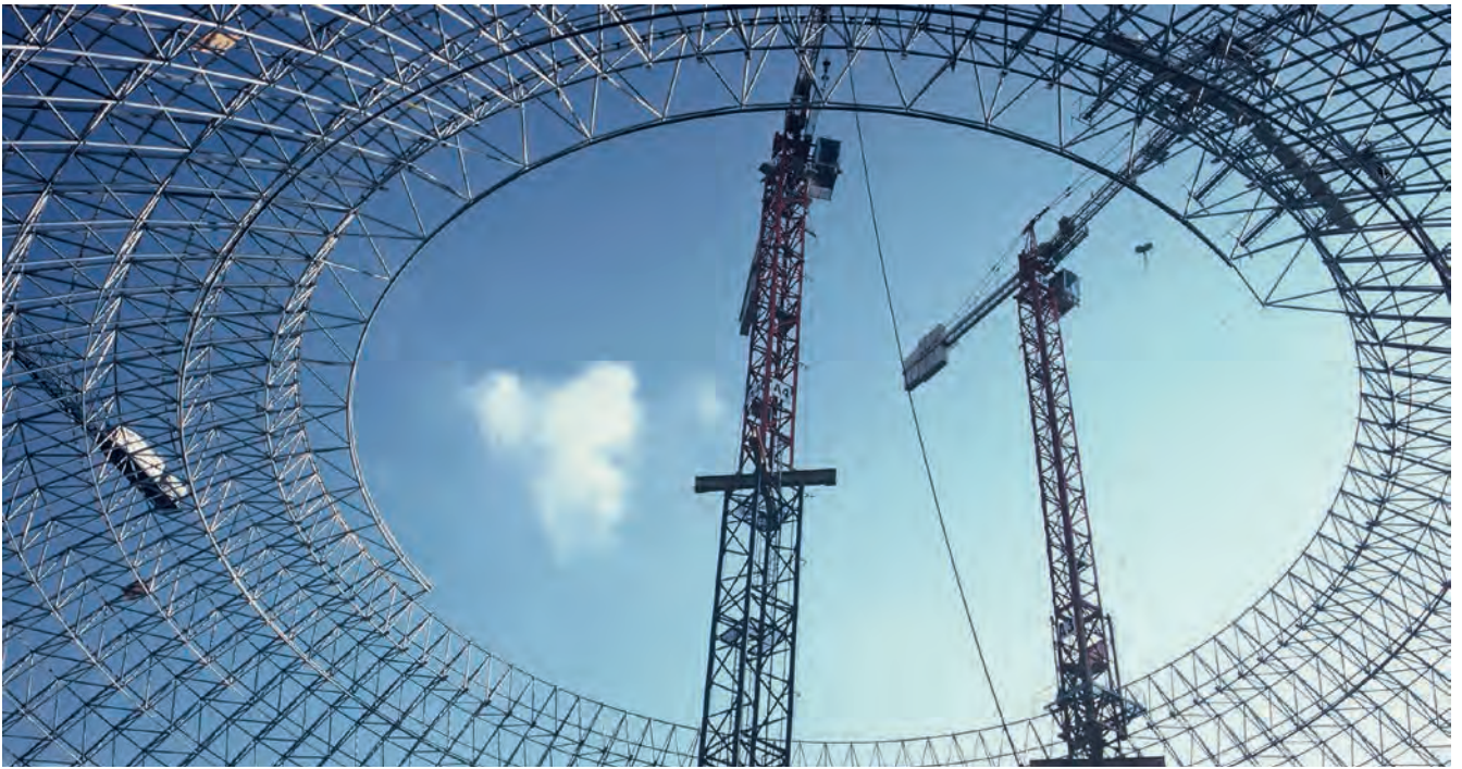
Rymdfackverk i Globens överstruktur under montering, sett från arenagolvet.
